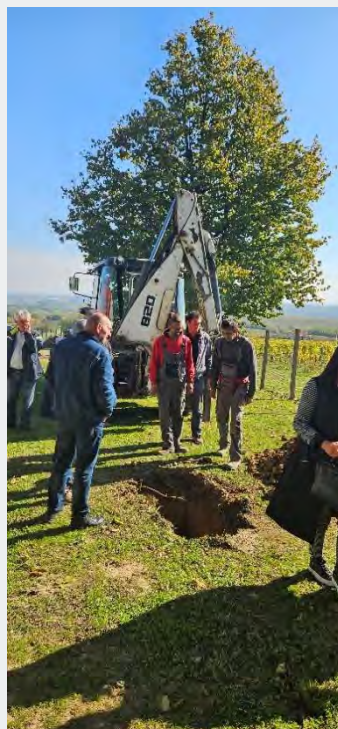
Slika 3. Pokušalište FAZOS – lokacija Mandićevac – Početak izgradnje Centra za prevenciju negativnih utjecaja klimatskih promjena u vinogradarstvu
